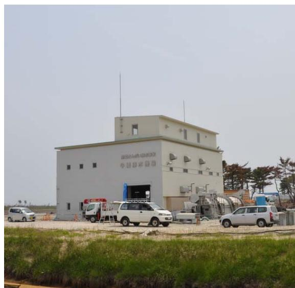
写真1 新牛橋排水機場 アンテナのついている3階部分に周辺の住民が避難した。津波は2階まで達した。
