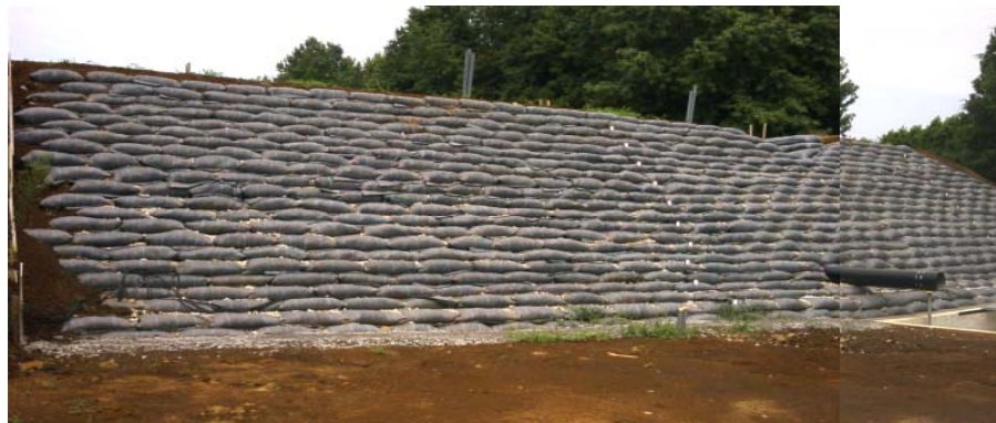
土のう工法を用いた実証試験
