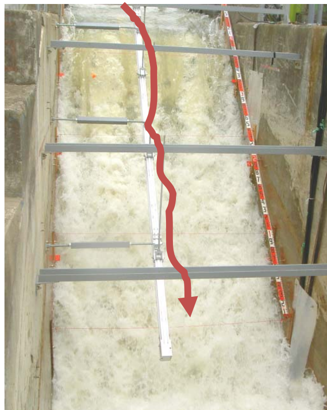
下流堤体斜面の法肩
