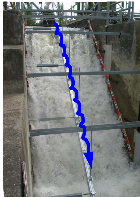
下流堤体斜面の法肩
