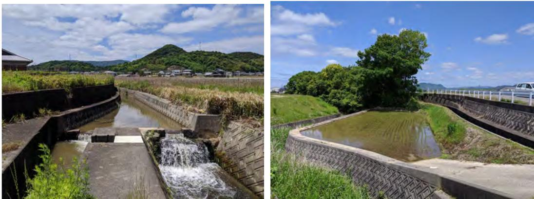
写真4 ため池への分水工（右）・ため池を縫って流下する用水路
