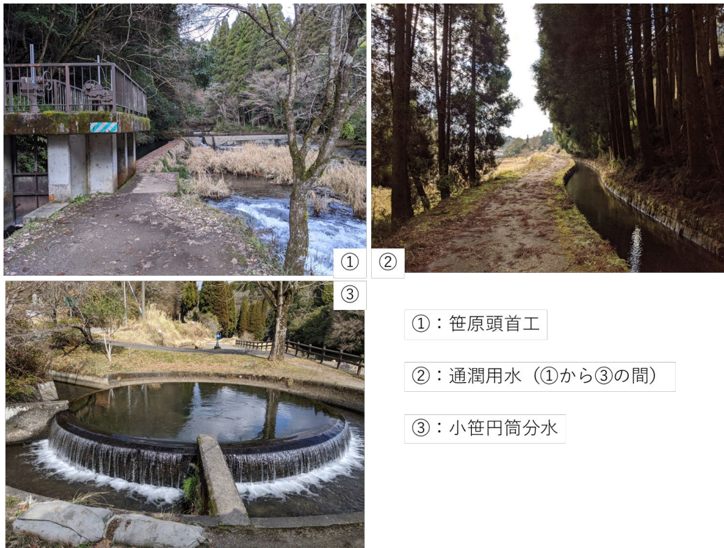
写真1 笹原頭首工周辺
