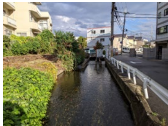
写真4 四つ洽の分水工（兵庫県伊丹市）
