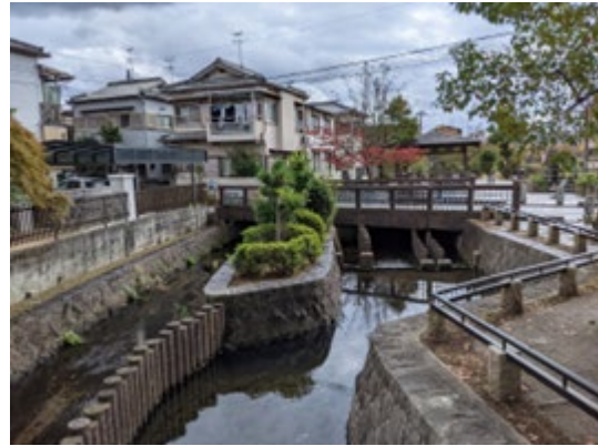
写真6 常吉源太郎橋周辺水路修景整備
