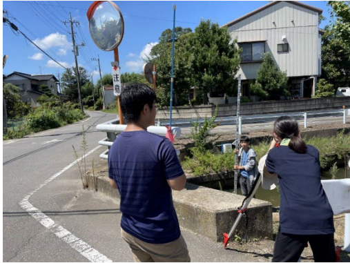
排水路横断測量
