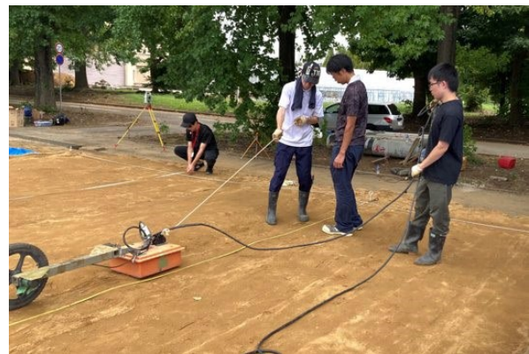
地中レーダーを用いた堤体探査の様子
