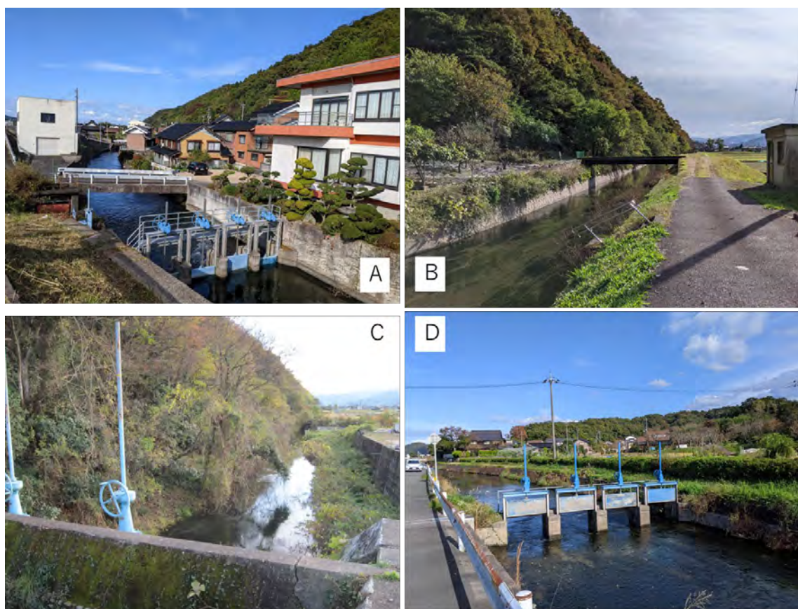
写真2 大口堰頭首工から百合用水堰まで
