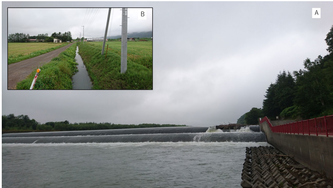
写真 2-1 千代田堰堤と水路
