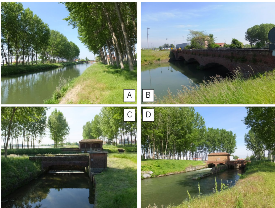
図5 ビアンドラーテ付近のカブール水路
