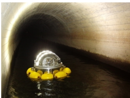
水路を点検中のロボット
