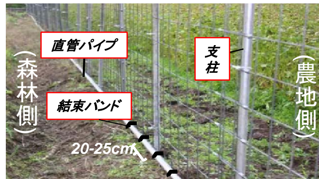
イノシシによるワイヤーメッシュ柵のくぐり抜けの痕跡
