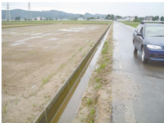
Fig.25 復旧された末端排水路 (旧淡路町岩野, 2005.7.4撮影) Restored farm ditch
