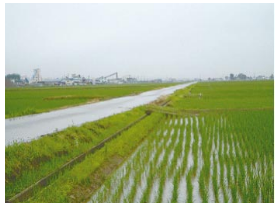
Fig.28 復旧された幹線農道 (旧淡路町岩野, 2005.8.28撮影) Restored main farm road
