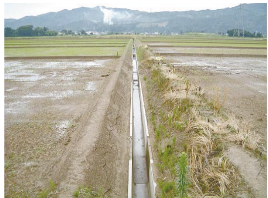
Fig.27 復旧された末端排水路 (旧淡路町岩野, 2005.7.4撮影) Restored farm drain
