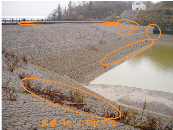
Photo 7 太田ダムの上流斜面の状況（全景）
