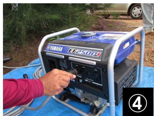
発電機への接続
