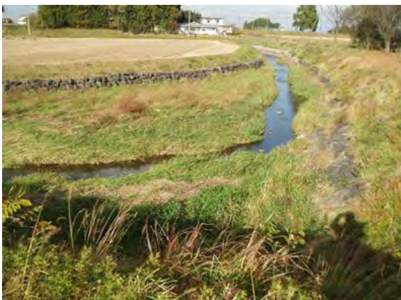
図 5-2 生態系配慮のための幅広水路区間
