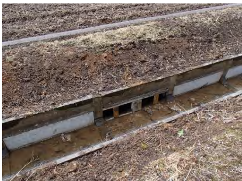
図 4-19 生態系配慮工法 1 完成状況
