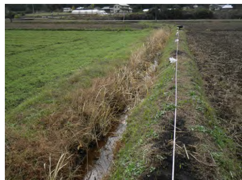
図 5-20 浚渫後 1 年経過（2016. 11. 20）
