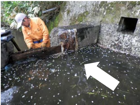
図5-7 用水路で堰上げ作業中の状況
