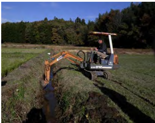
図 5-4 小型油圧ショベルによる浚渫
