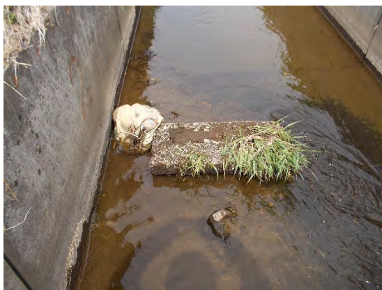
図 4-14 水路壁とバープ工法の間隙間に設置された土嚢（左）と堆積土砂の状況（右）
