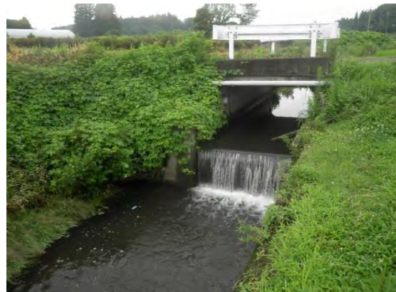
図5-10 用水路での堰上げ後の状況
