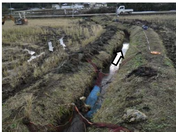
図5-12 浚渫区間の上下流端に設置した小型定置網
