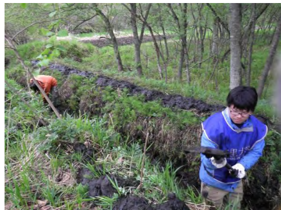
図 5-5 手掘りによる浚渫
