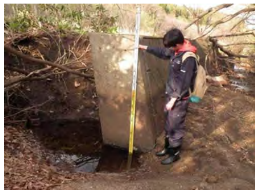
図 4-22 被災現場での簡易測量
