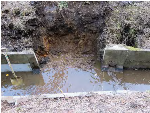
図 4-17 ベンチフリューム設置場所の掘削
