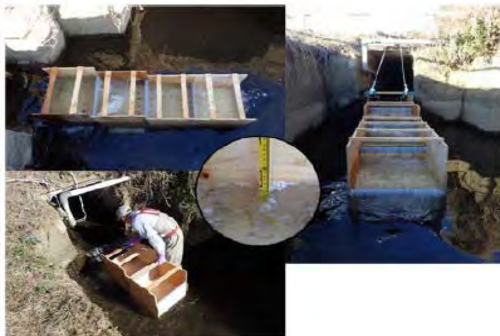
図4-9 施工の様子と施工後の状況
