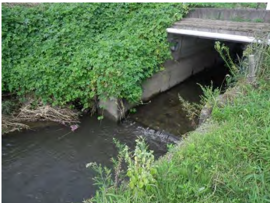
図5-9 用水路での堰上げ前の状況
