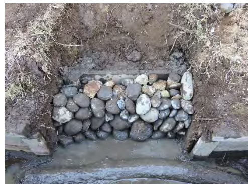
図 4-20 生態系配慮工法 2 完成状況
