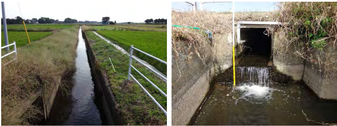
図4-8 落差工解消対照の支線排水路
