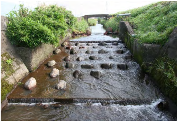
図4-2 粗石付き斜路式魚道の概観
