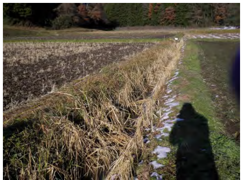
図 5-21 浚渫後 2 年経過（2017. 11. 25）
