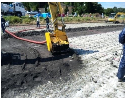
固化剤を用いた削り取り
