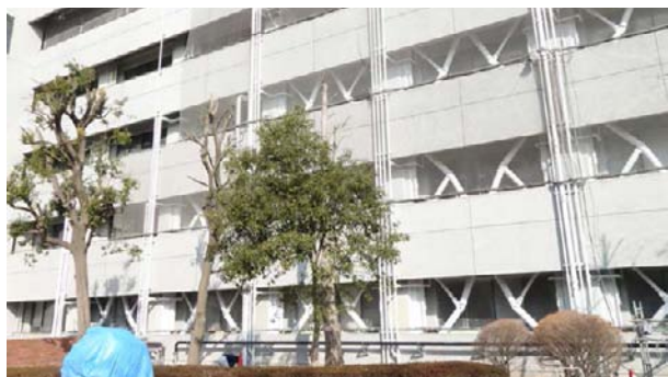
研究本館耐震改修工事
