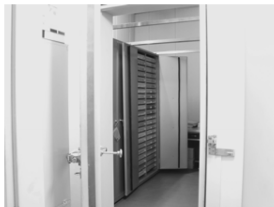
図1 タイプ標本室、手前は防火扉
