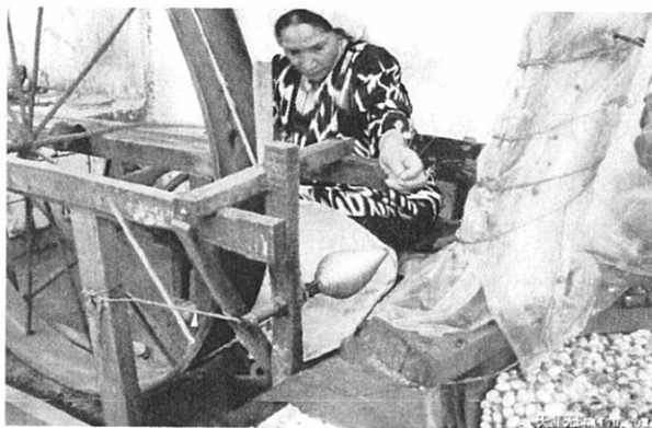
図 22 糸紡ぎ車利用の生糸の巻き取り
