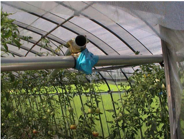
図1 支柱の連結金具が突き出ているので、目立つように青色のテープを巻いています。
