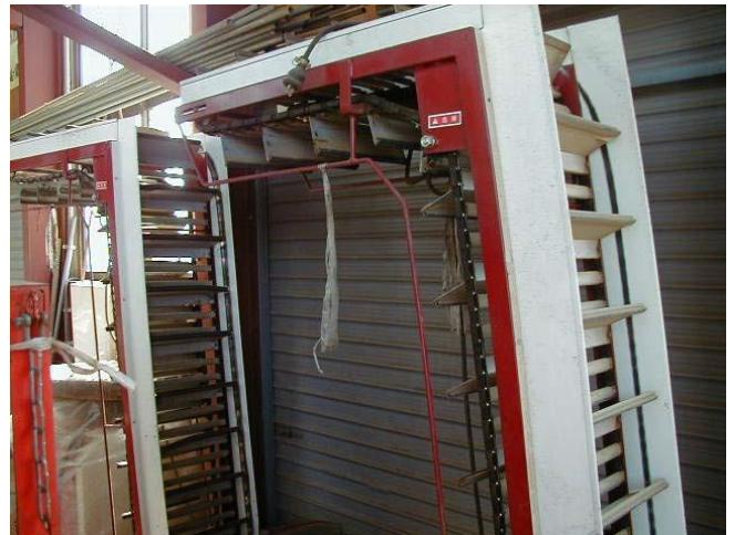
図2 ヒモをぶら下げているので、上方にコンベヤがあることに気付きます。
