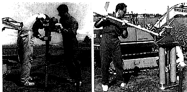
第2図 作業概要 (左: 打込作業, 右: 引抜作業)
