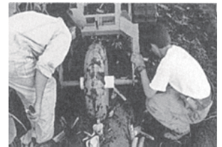
写真2 畦上方圧縮方式 （ドーナツローラ式）
