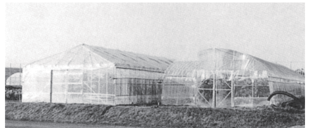
写真3 山形トラス構造ハウスとアーチ型ハウス
