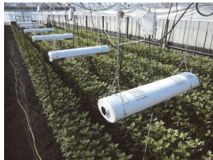
図1 ヒーターによる加温状況
