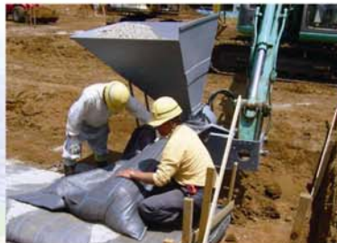
土のうの作成
