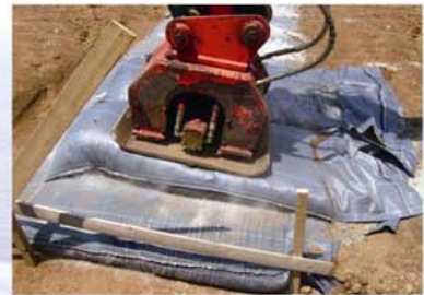
土のうの転圧
