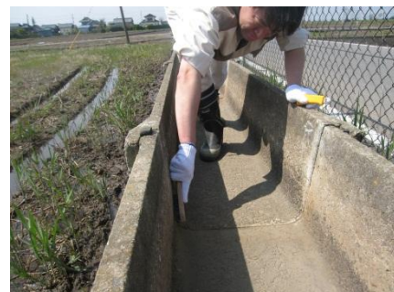
① ワイヤブラシによる施工面の清掃
