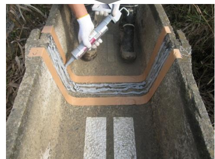
② シーリング材の塗布・表面成形
