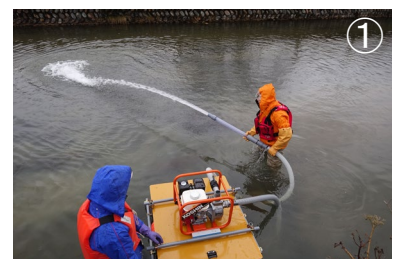
① 水流で水草を吹き飛ばして除去します。省力化、作業適期を調べました。
