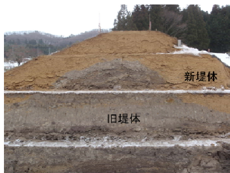
図2 古い堤体があるため池の断面
