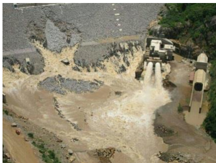
堤体の中央部から水が流出している。
