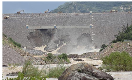
堤体の中央部から水が流出している。
