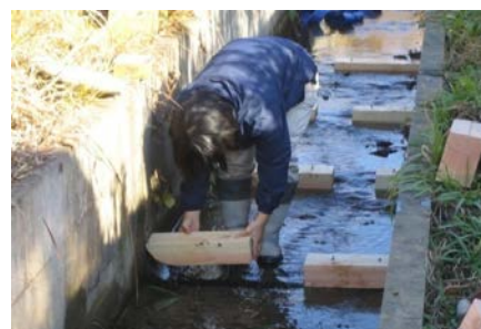
排水路にて水制設置中
