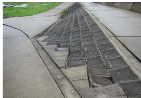
熊本地震による海岸堤防の被害状況
