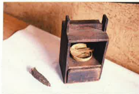
掘削工事に使用した道具 (のみ、灯台)
