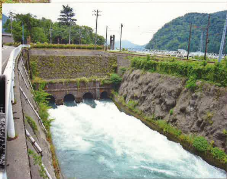
現在の給水口
