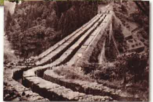
当時の通潤橋 吹上樋の全容
