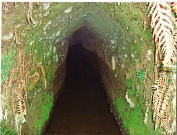
水路トンネル内部
