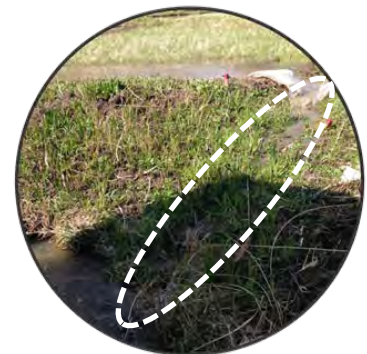
写真2 水田から水路への土羽流路
