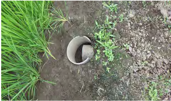
写真5 塩ビ管水尻構造の水田（茨城県）
