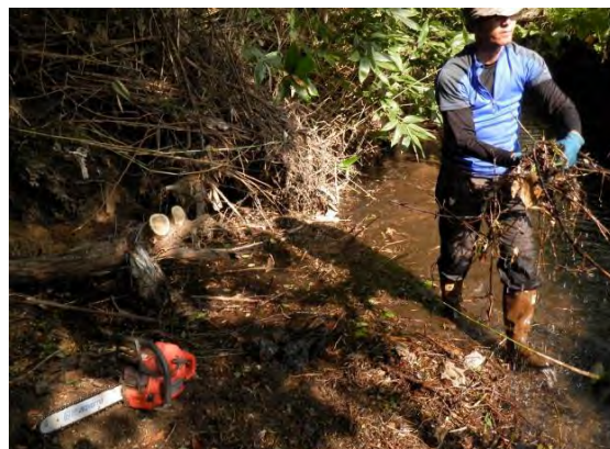
図5-6 排水路での伐採状況
