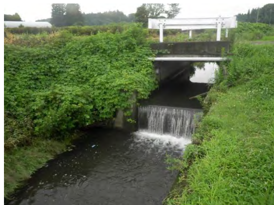
図5-10 用水路での堰上げ後の状況
