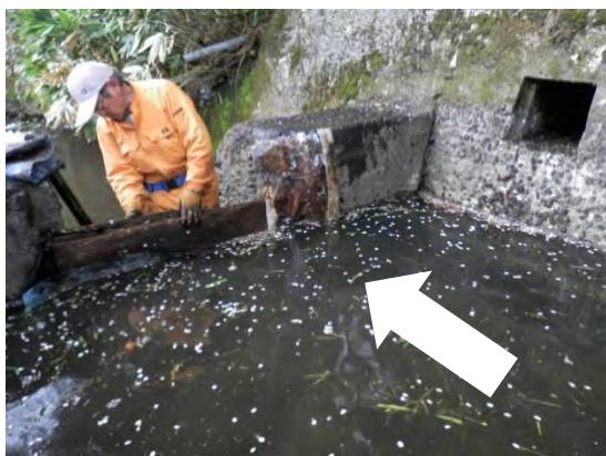
図5-7 用水路で堰上げ作業中の状況
