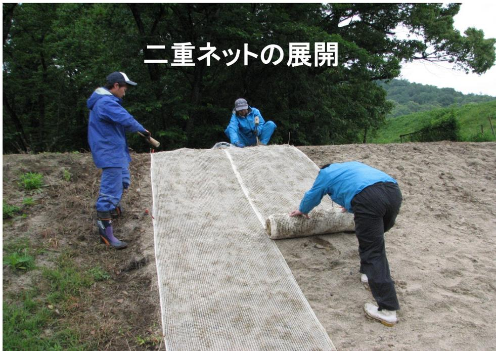
二重ネットの展開は、畦畔法面の規模、形状に沿って、縦方向(上図、天端40m、法長2m、斜度35°)、横方向(表紙上図、天端20m、法長2m、斜度35°)、双方に、可能です。
